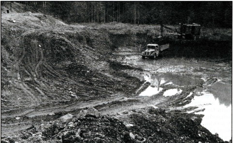
Obr. 4 – Hlavním zdrojem plavienin je hustá a poškozená síť lesních komunikací. Na snímku je tzv. Maxova nádrž v údolí Smradlavé (povodí Bílé), z níž jsou sedimenty odtěžovány a uvolněný prostor bude sloužit jako jeden ze sedimentačních prostorů pro sedimentaci plavienin nad vodárenskou nádrží Šance (tyto nádrže byly budovány koncem minulého století).
