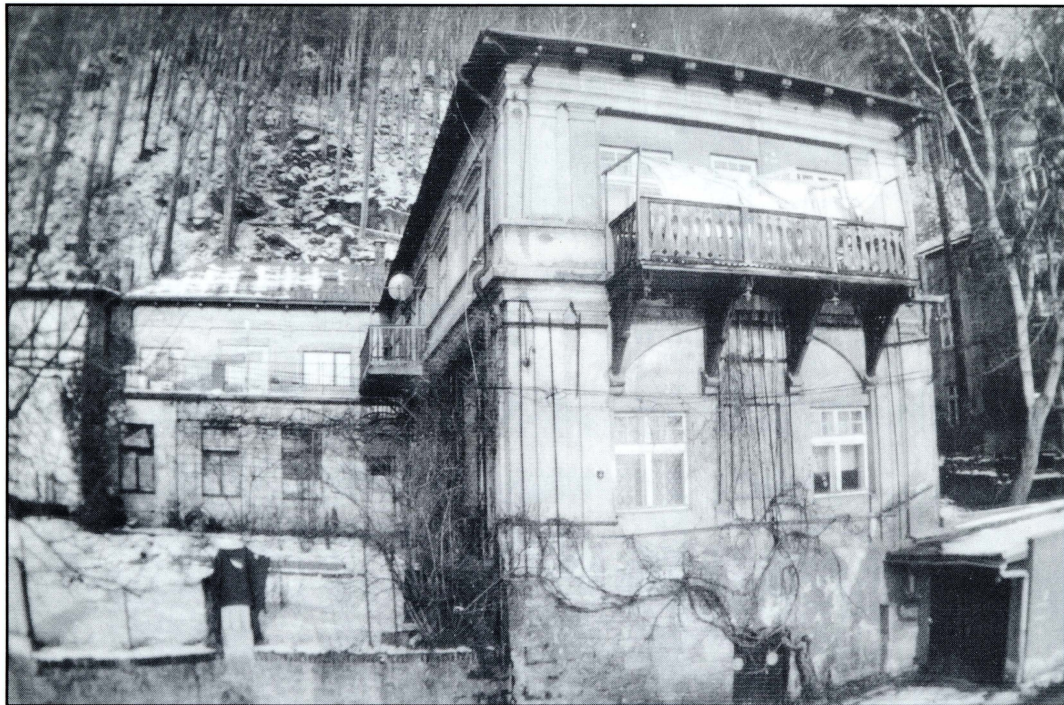
Vlastní budova lázní Sv. Josefa po přestavbě v roce 1846. Dnešní stav jako obytný dům.
