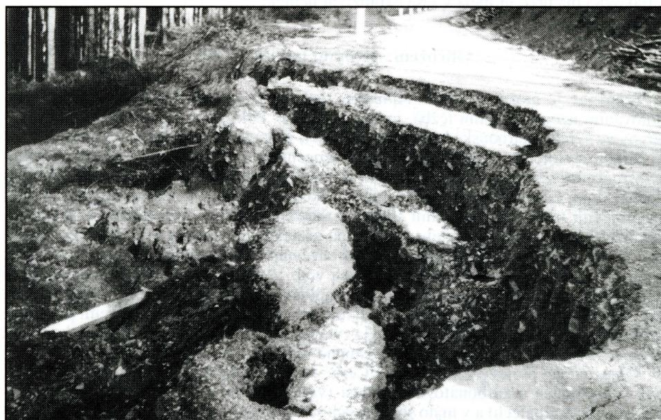
Obr. 2 – Sesuvem poškozená lesní silnice na svazích Velkého Lopeníku u Březové. Zvětraliny flyšových hornin jsou náchylné ke vzniku oslabených zón vlivem zvýšení obsahu vlhkosti. Snímek R. Švehlík.
