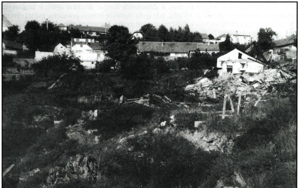
Obr. 1 – Po děletrvajících srážkách v r. 1985 byla část obce Budkovice v jv. části Boskovické brázdy u Moravského Krumlova zničena sesuvem. Mezi příčiny svahového pohybu náleží podemlání údolního svahu řekou Rokytnou, objemové změny v jilech otnangu (neogén) a neuvážené antropogenní zásahy (svod dešťové kanalizace aj.). Snímek M. Hrádek.
