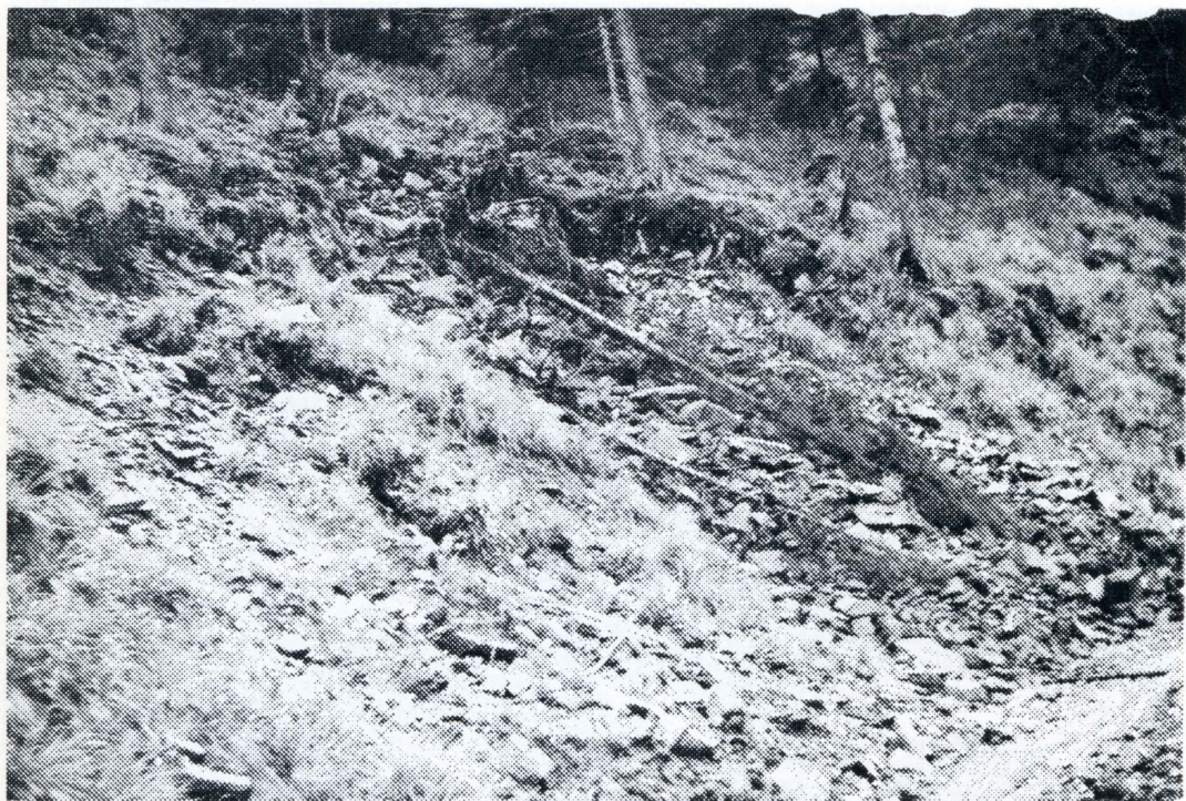
6. Sescuvání způsobené intenzívními srážkami v nejvíce provlhčené části svahu.
