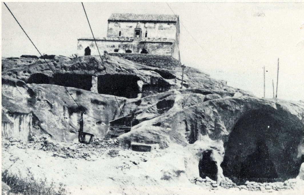
3. Rekonstrukční práce probíhající v dolní části antropogenního jeskynního komplexu Uplisciche.
