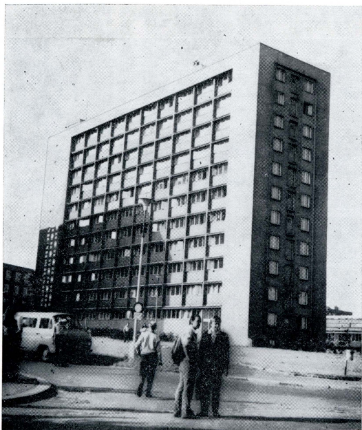
3. Areál průmyslových škol — elektro-technické a dopravní — s kolejemi, kde byla ubytována většina účastníků XIII. sjezdu čs. geografů.
