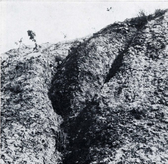
8. Detail erozní rýhy na výsypce Václav. (Snímky J. Loučková)
