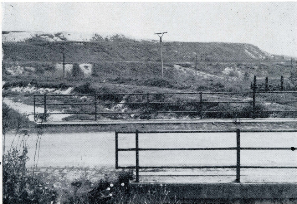
1. Stupňovitě upravený okraj Osecké výsypky.
