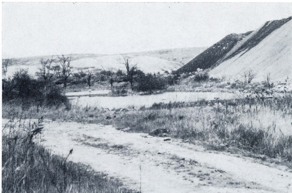
3. Předpolí Kopistské výsypky v okolí bývalé obce Souš, zaplavené vodou vytlačovanou váhou výsypky.
