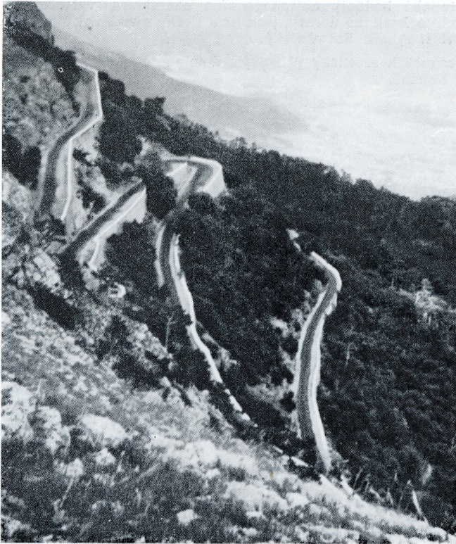
7. Typická „via panoramica“ — vyhlídkový úsek cesty v terénu s velkými výškovými rozdíly. Na snímku silnice z Jalty do Bachčisaraje na Krymu, vinoucí se od moře do svahů Jajly.
