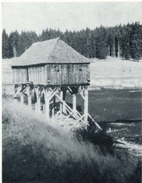
1. Stavidlový přístřešek na Pohořském rybníku, který jediný se dochoval dodnes. (Foto S. Kučera, 1963)
