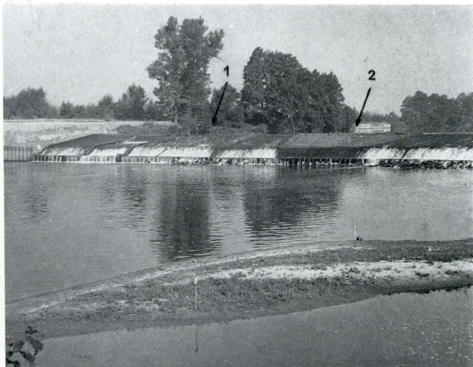
1. Rekonstruovaný jez na Labe severových. od Opatovic n. L. Vysvětlivky: 1 — hrdlo Opatovického kanálu z doby Viléma Pernštejna; 2 — dnešní hrdlo kanálu.
