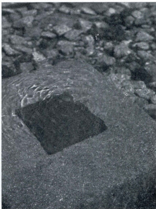
Obr. 2. Bývalý přepadový odtok pro odvod nadnormální vody v jihozápadním cípu Štrbského plesa. Stálá rotující vodní tromba v jeho hrdle. (Foto A. Bečvář.)
