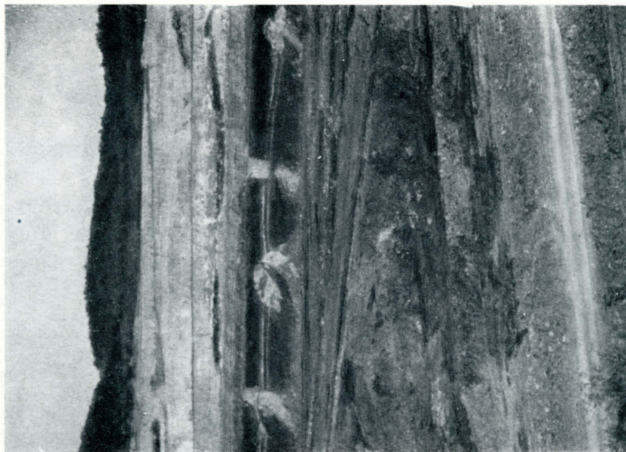
Profil stěny povrchového lomu se závaly starých komor starší hlubinné těžby (světlé plošky tmavé uhelné sloje). (Foto Dosedla)
