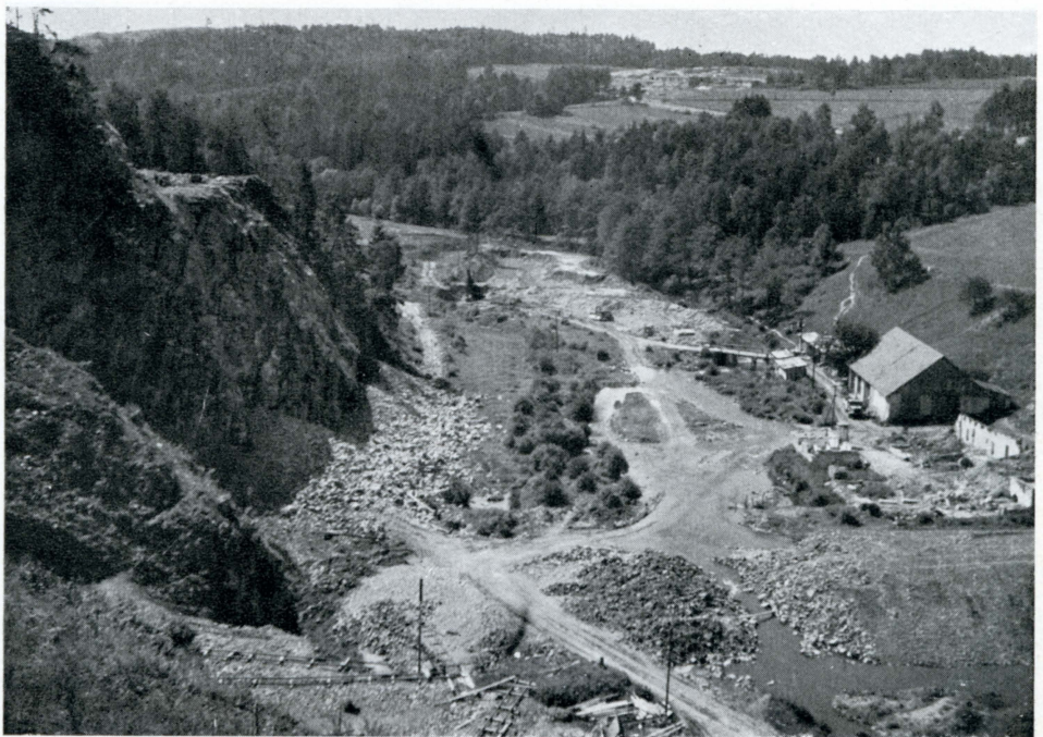
Údolí řeky Oslavy v místě projektované hráze, pohled po vodě. Vlevo, granitové skály. Foto J. Linhart
