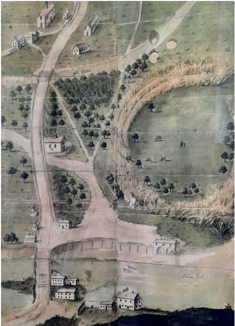
Obr. 2 – Náčrt krajiny mezi Brandýsem n. L. a Starou Boleslaví – v pohledu od J k S (Franz 1732). Kromě polohy hlavního a vedlejšího ramene Labe je na skice zachycen jez v hlavním řečišti a dřevěné opěvnění pravého břehu Labe před dřevěným mostem.
