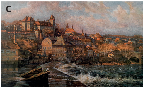
Obr. 4 – Vývoj úseku Labe pod zámek Brandýs n. L. v 18.-21. století zobrazuje základní změny charakteru brandýského jezu (levá část snímků) od tzv. staropražského typu (A) po současný pohyblivý jez (D) a typů opevnění břehů. V pravé části snímků je zachycen most mezi Brandýsem n. L. a Starou Boleslaví. Původní dřevěný most (A, B) byl nahrazen kamenným (C) a později železobetonovým mostem (D). A – Venuto (1764–1833), B – Hebera (1848), C – Procházka (první polovina 20. století), D – 2021.
