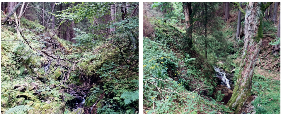
Obr. 8 – Pozůstatky klauz v terénu: zřetelné pozůstatky hráze na obou březích Vavřincova potoka (vlevo), zbytky hráze po klauze na Lysečinském potoce (vpravo). Foto E. Šádková.
