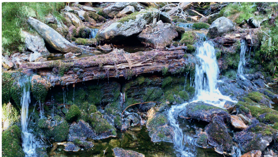
Obr. 1 – Základové trámy v místě hráze klauzy na Jelením potoce ve Lvím dole. Foto E. Šádková.
