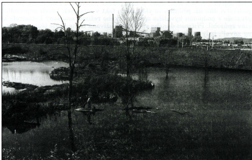
Obr. 3 – Poklesem zcela zdevastované centrum bývalé Karviné u Dolu ČSA, železniční trať prochází po rekonstrukci vysokým náspem přes zvodnělou depresi. Snímek J. Havrlanta z roku 1990.
