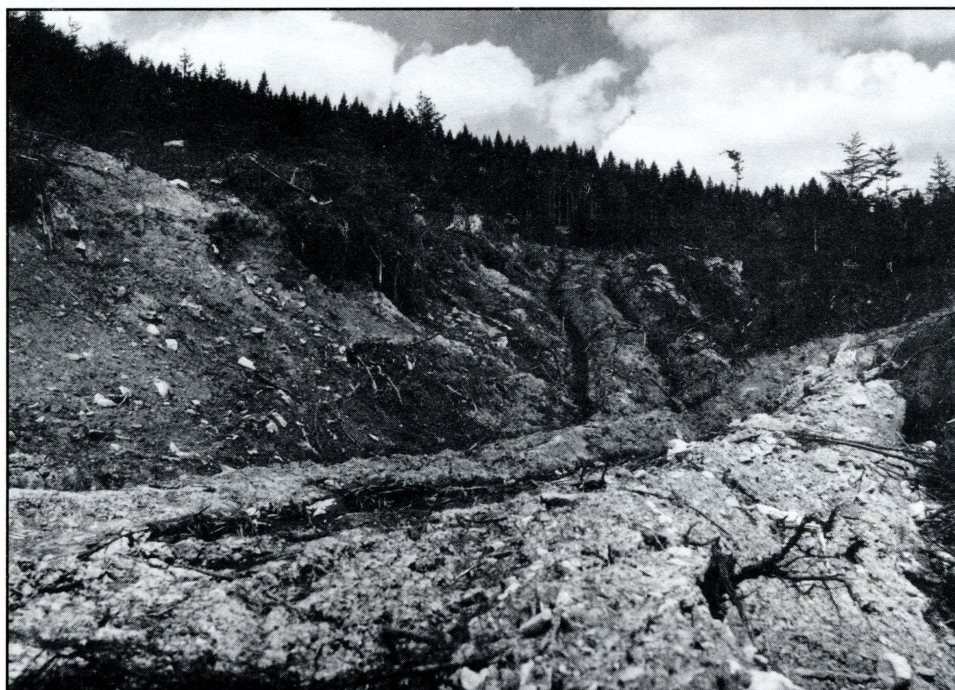
Obr. 3 – Traktory poškozená lesní komunikace v povodí Bílé. Snímek L. Buzek.
