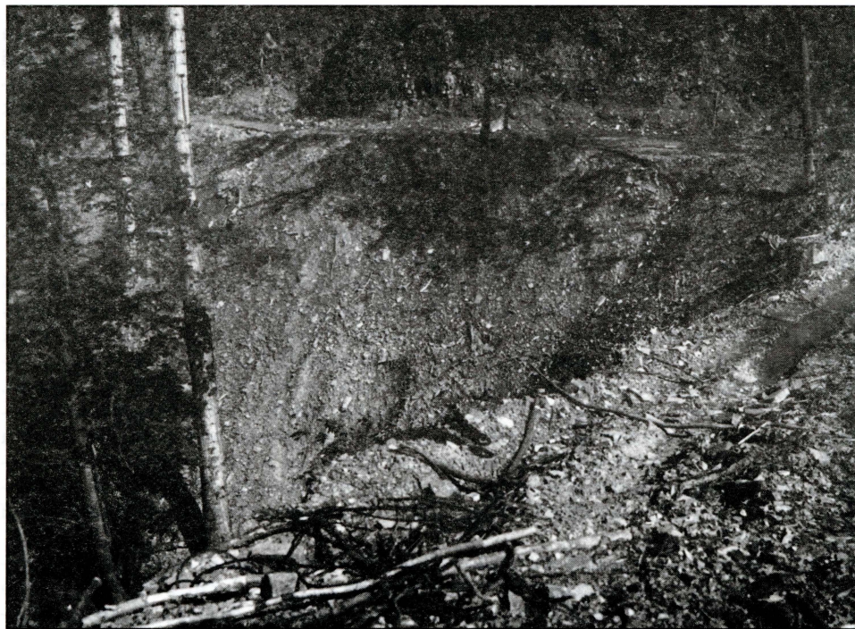
Obr. 5 – Nezanedbatelným zdrojem plavenin je hustá a poškozená síť lesních komunikací
