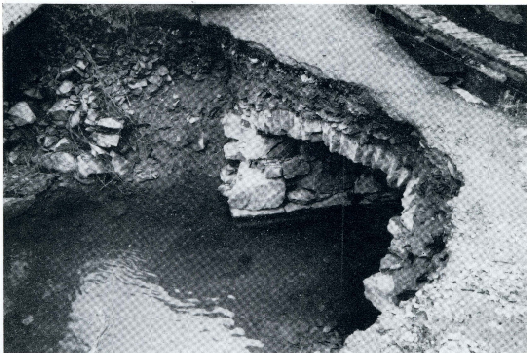
3 — Tisá v Novém Libouchci — úsek pod protrženou rybníční hrází.
