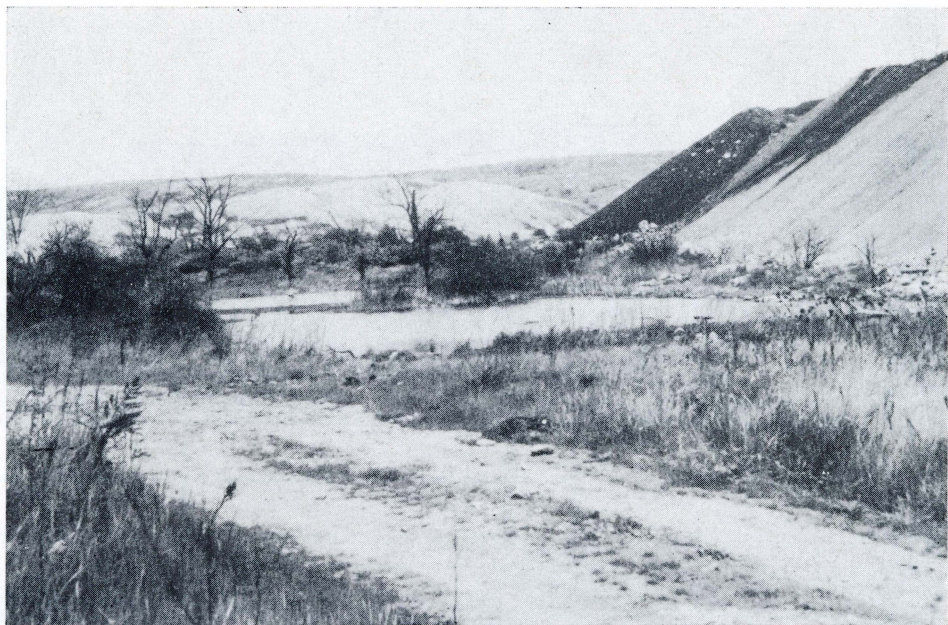
3. Předpolí Kopistské výsypky v okolí bývalé obce Souš, zaplavené vodou vytlačovanou váhou výsypky.
