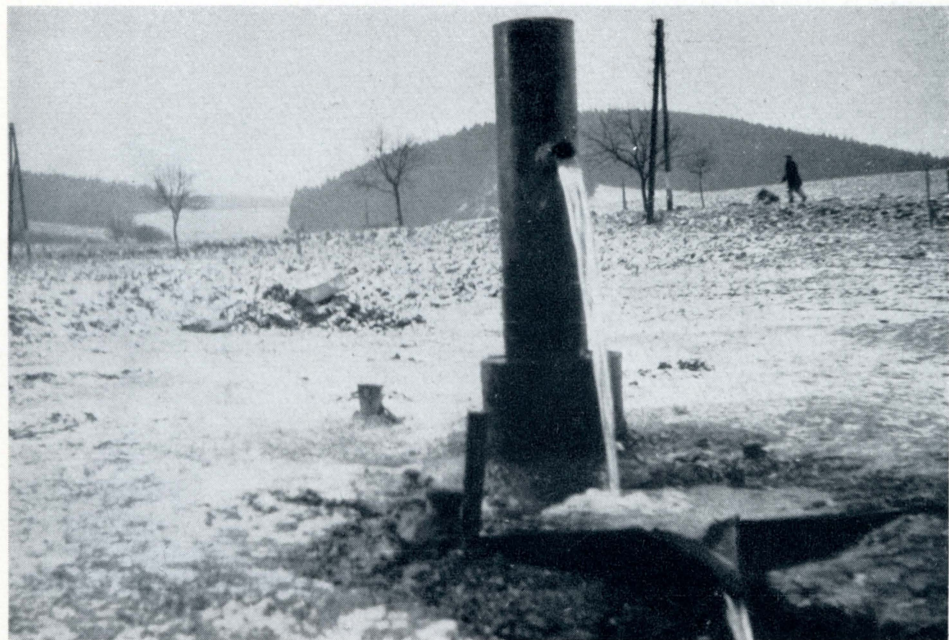
Obr. 1. Přepad vody ve vrtu ve výši 1 m nad terénem.
