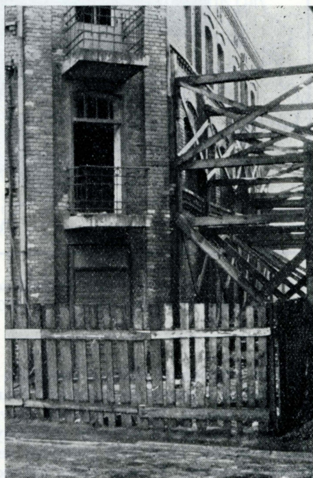
Zabezpečování domů při škodách způsobených poddolováním v Katowicích-Brynowě. Foto J. Szaflarski
